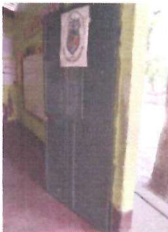
PUERTA, SUSTITUCION DE PUERTA
