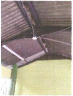
ESTRUCTURA DE TECHO, CAMBIO DE ESTRUCTURA DE TECHO, CUBIERTA DE LAMINA, SUSTITUCION DE CUBIERTA DE LAMINA
