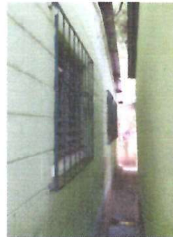
MANTENIMIENTO A BALCONES, VENTANAS, SUSTITUCION DE VENTANAS POR VENTANAS DE PVC AULA TELESECUNDARIA
