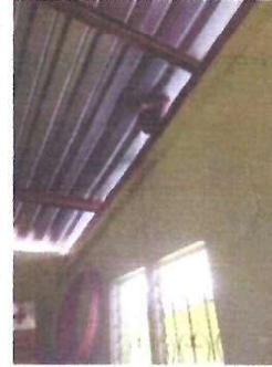
ESTRUCTURA DE TECHO, MANTENIMIENTO ESTRUCTURA DE TECHO, CUBIERTA DE LAMINA, SUSTITUCION DE CUBIERTA LAMINA TROQUELADA EN AULA DE TELESECUNDARIA
